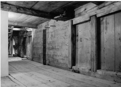
Abb. 163: Splügen, Herberge Weisses Kreuz. Korridor im zweiten Obergeschoss.
