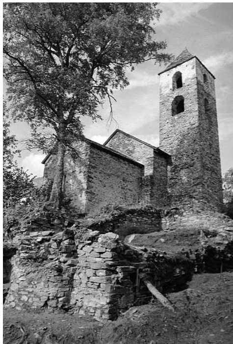
Abb. 16: Sils i. D., Burganlage Hohenrätien. Die Ruine des Baptisteriums nach dem Entfernen des Abbruchschutts. Dahinter die heutige Kirche der Burganlage. Blick von Nordosten.
