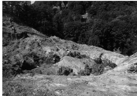
Abb. 44: Untervaz, Haselboden. 3. Etappe; Humusabstoss nach den Ausgrabungen: Felstrichter im Bereich des Feldes 2 und westlich davon. Ansicht von Osten.
