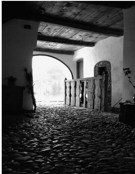
Abb. 160: Splügen, Herberge Weisses Kreuz. Die Eingangshalle im Erdgeschoss mit Bol- lensteinpflasterung.
