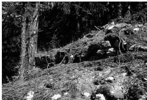
Abb. 5: Müstair, Balcun At. Letzte Steinlagen der Nordwestecke der westlichen Burgmuer, August 2000, vor der Bestandessicherung.
