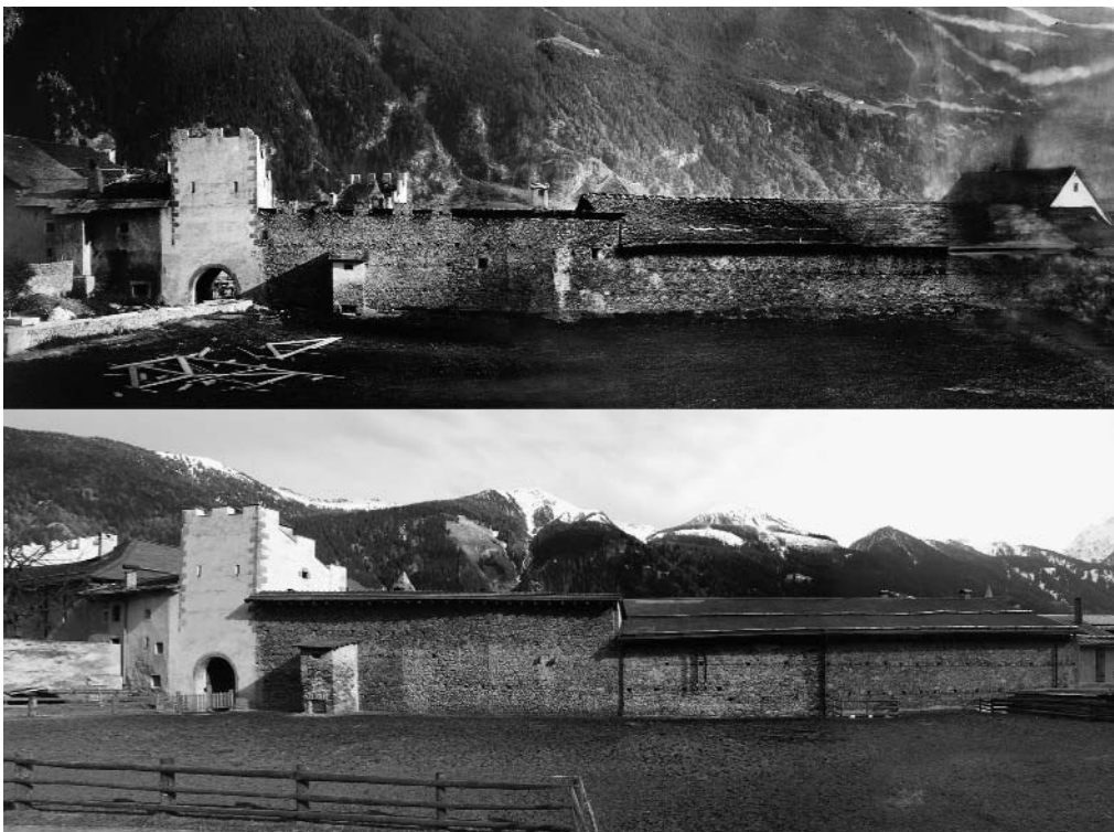
Abb. 14: Müstair, Kloster St. Johann. Nordfassade des Landwirtschaftstraktes; Blick gegen Süden: Oben Aufnahme von Josef Zemp mit Zustand von 1904, unten Zustand 2002. In der Zwischenzeit waren im mittleren Abschnitt Schweineställe unter einem Pultdach an die Klostermauer angebaut.
