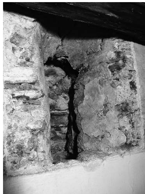
Abb. 13: Müstair, Kloster St. Johann. Ehemalige West- fassade des Plantaturms im 1. OG: Originales Rundbo- genfenster mit verlorenem hölzernem Fenstergericht aus dem 10. Jh.; Blick gegen Westen. Oben Firstbalken des spätgotischen Kreuz- gangdaches (1517, 1602 er- neuert).
