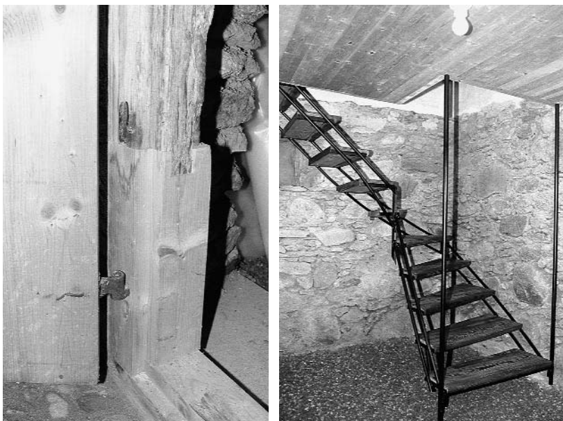
Abb. 177: Schnaus, Casa Oswald. Die neue Treppe vom Keller ins Wohngeschoss.
