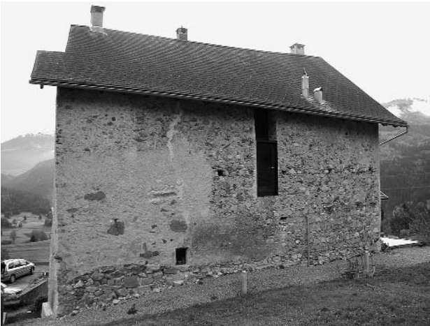
Abb. 135: Brienz/Brinzauls-Vazerol, Tgesa Gronda. Der neue Zugang von Norden in die Wohnung des zweiten Geschosses. Als Material wurde Eisen gewählt, um den Eingriff in die historische Substanz lesbar zu machen. Die den Eingang erschliessende Aussentreppe fehlt noch.
