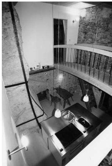
Abb. 143: Brienz/Brinzauls-Vazerol, Tgesa Gronda. Die Küche im zweiten Stock. Auch hier wurden die alten Bestandteile erhalten. Der bestehende Kamin musste mit einem "Eisenkorsett" gesichert werden. Die Galerie verbindet die beiden Kinderzimmer durch die zweistöckige Küche.
