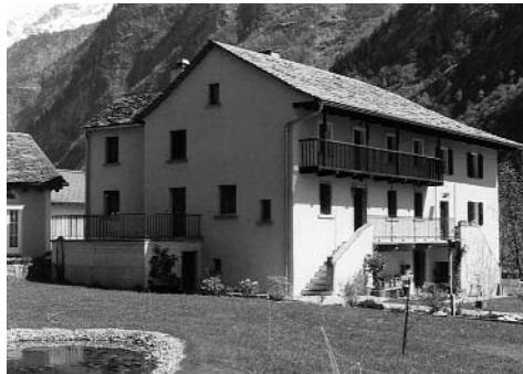
Abb. 105: Lostallo-Cabbiolo, Wohnhaus Nr. 97. Ansicht von Südwesten.
