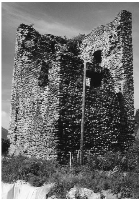
Abb. 121: Zizers, Burgruine Friedau. Ansicht von Südwesten. Zustand vor den Sicherungsarbeiten 2001.
